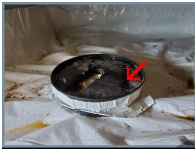
Sump pump pit.
